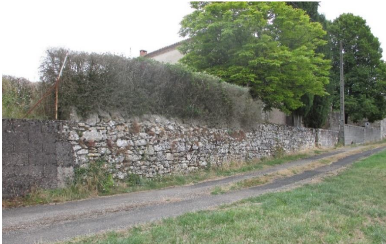
Murs de soutènement en pierre sèche, le cordais vers Mouzieys-Panens
