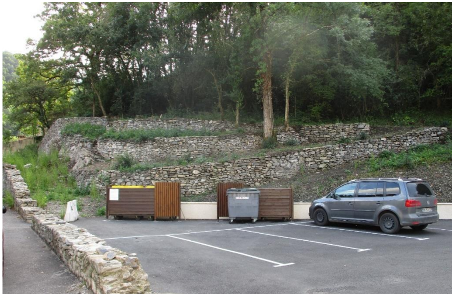
Murs de soutènement du chantier Concordia 2019, à Burlats
