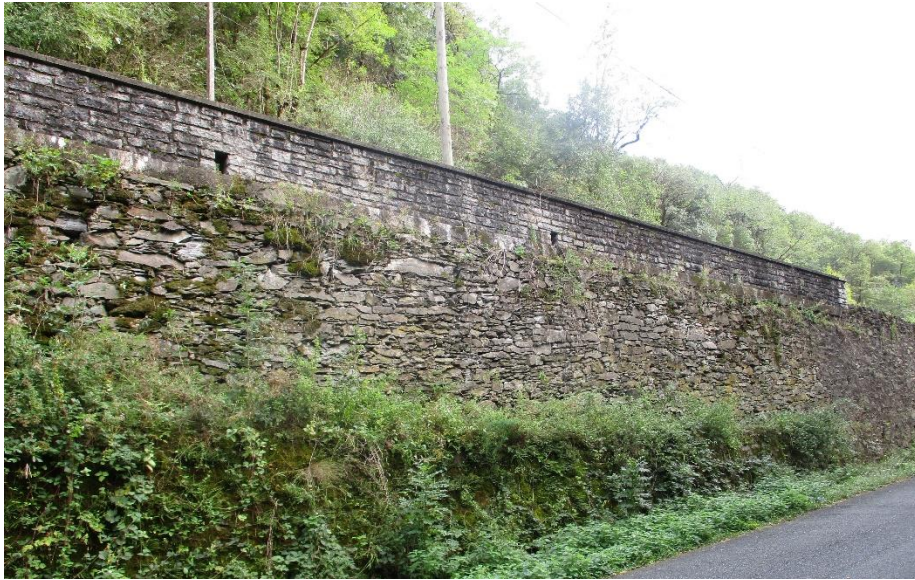
Ouvrages de soutènement routier entre Burlats et Lacrozette
