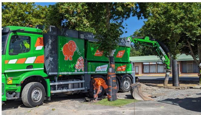
Platanes maintenus en place. Enrobés sciés puis excavation jusqu'à - 40 cm par aspiration.
