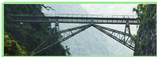
Viaduc du Faux-Namti, Chine, 1910 (voir page 16)
