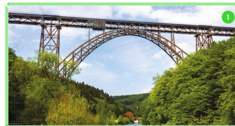
1 le Viaduc de Mungsten , Allemagne, (1893-1897, Anton Von Rieppel), villes de Solingen, Remscheid, Wuppertal the Mungsten Viaduct , Germany, (1893-1897, Anton Von Rieppel), towns of Solingen, Remscheid, Wuppertal
