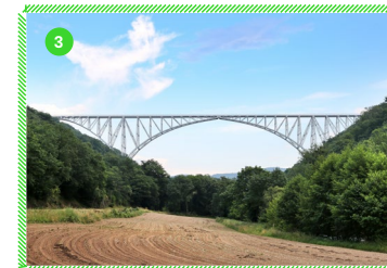
3 le Viaduc du Vaur , France, (1895-1902, Paul Bodin), communes de Tanus et Tauriac-de-Naucelle the Vaur Viaduct , France, (1895-1902, Paul Bodin), towns of Tanus, Tauriac-de-Naucelle
