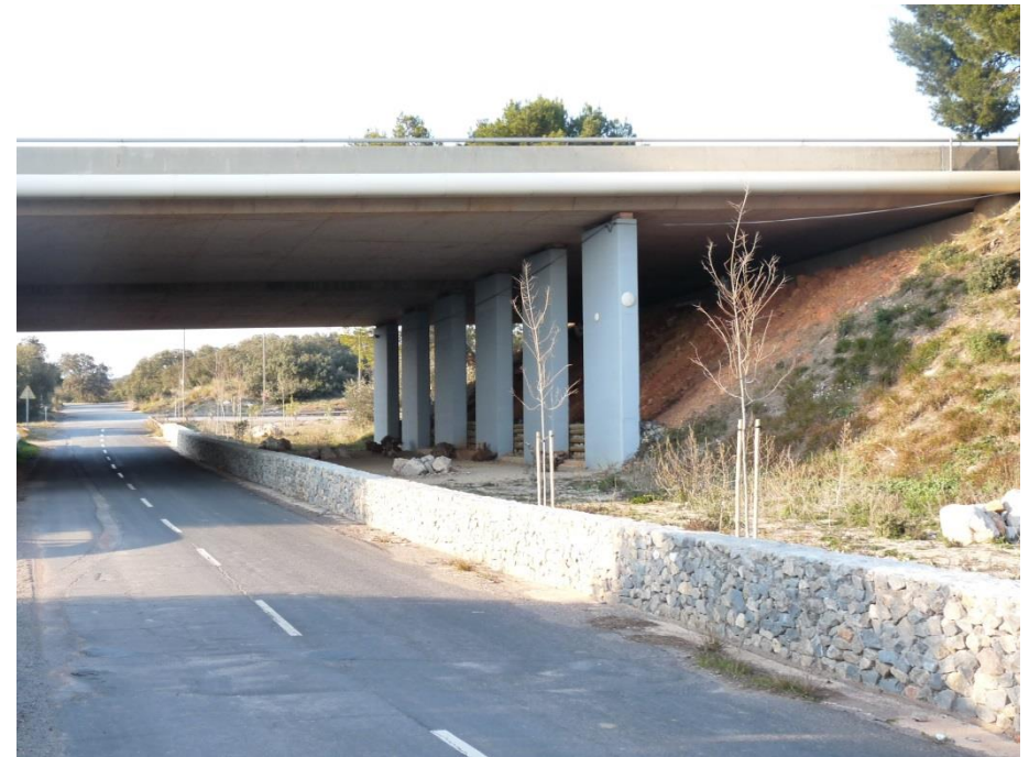
Exemple : un passage pour la faune terrestre aménagé sous l'A9 (Commune de Poussan – 34).
