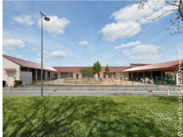
Cour et bâtiments après rénovation - 2026
