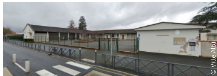
Cour et bâtiments avant rénovation - 2023
