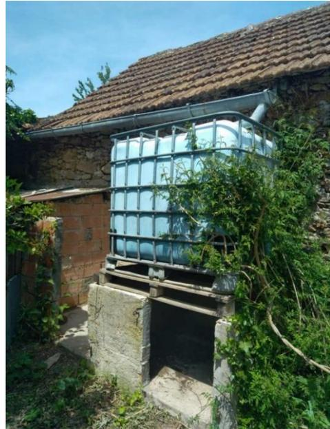
*Installation de la chaudière Apitotal servant pour la pratique de l'apiculture et la myciculture (à gauche) et installation du système de récupération d'eau de pluie (à droite)*
